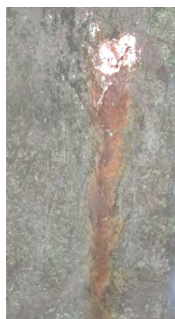
Photos 17, 18, 19 et 20: Eisenstab vor der Behandlung, nach der Bohrung, eingefügter und geschmiedeter Kupferstab, weniger deutliche Fließspuren nach der Sandstrahlung
