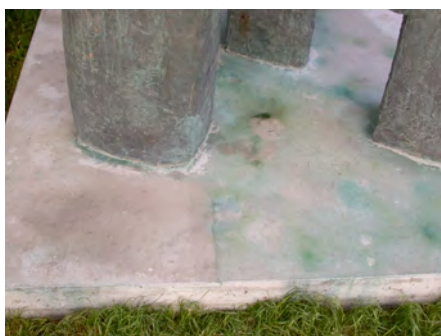
Photo 21: Behandlung zur Entfernung des Kupfersalzes in Gange
