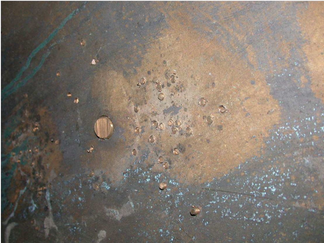
Figure 17:Innenansicht: Detail der Reparaturen mit Bronze-Gewindestäben.
