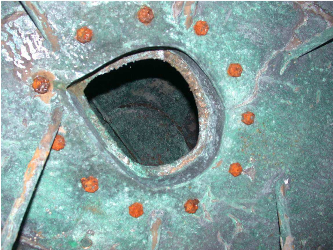
Figure 15: Innenansicht: Verschraubung der unteren mit der mittleren Schale.
