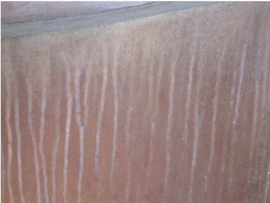
Figure 7: Laufspuren durch Wassereinfluss.
