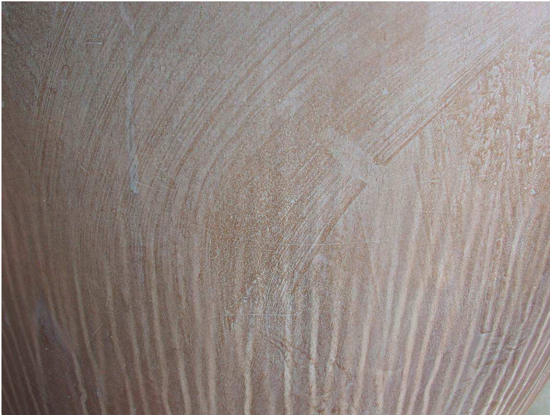
Figure 9: Breite Pinselstriche von früherer Behandlung sind deutlich sichtbar und haben sich in die Oberfläche „eingefressen“.
